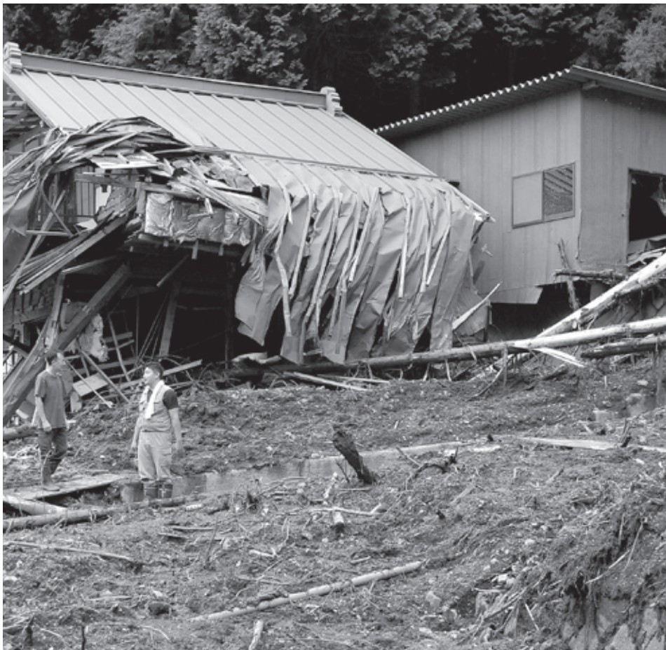
世附地区の土砂崩れにより半壊した家屋
