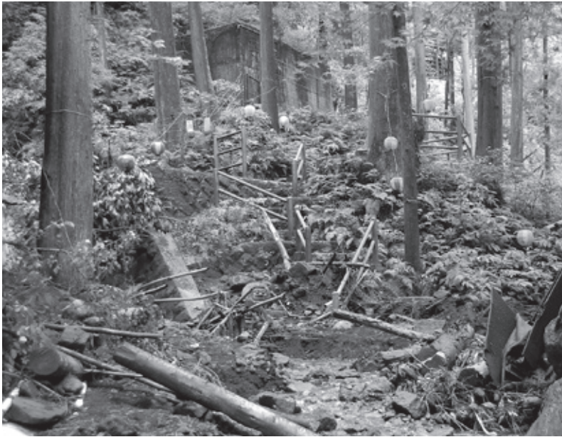
土砂や落石により崩壊した洒水の滝 新観瀑台付近
