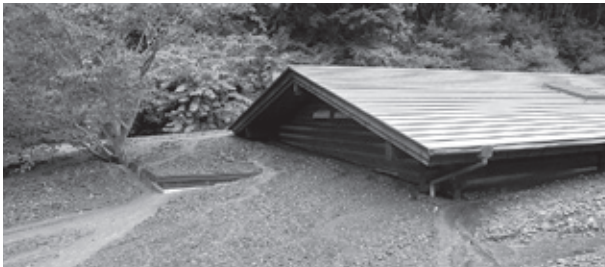
ふれあいビレッジ オートキャンプ場の炊事場が土砂によって埋没した
