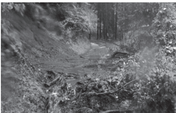
土砂崩落により通行止めとなった町道深沢線
