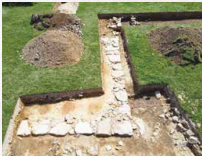
米蔵建物の基礎
