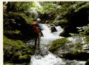
⑦ 釜のある1m滝の先に8m堰堤
